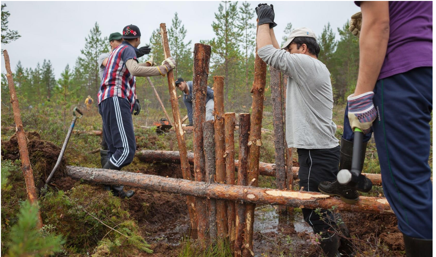
Kehikon rakennus alkuvaiheessaan. Padon kohdalta on jo kuorittu pintamaa pois ja ulommat vaakapuut asetettu paikoilleen. Sisemmät vaakapuut helpottaisivat lekomista. Keuruu, Raatosuo. Kuva: Ville Kangas.
