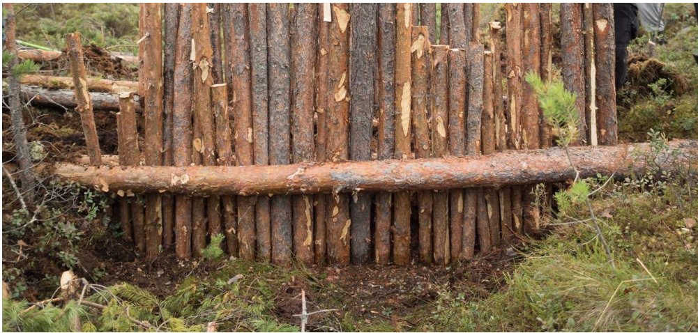
Kehikon rakennus alkuvaiheessaan. Padon kohdalta on jo kuorittu pintamaa pois ja ulommat vaakapuut asetettu paikoilleen. Sisemmät vaakapuut helpottaisivat lekomista. Keuruu, Raatosuo. Kuva: Ville Kangas.
