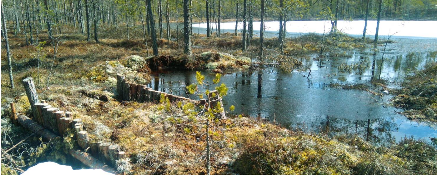
Suolammen pintaa on nostettu kaivettuun laskuojaan rakennetulla tavanomaisella puu-turvepadolla. Vesi kiertää pienenä norona padon vierestä. Multia, Pieni Kalliolampi. Kuva: Matti Aalto
