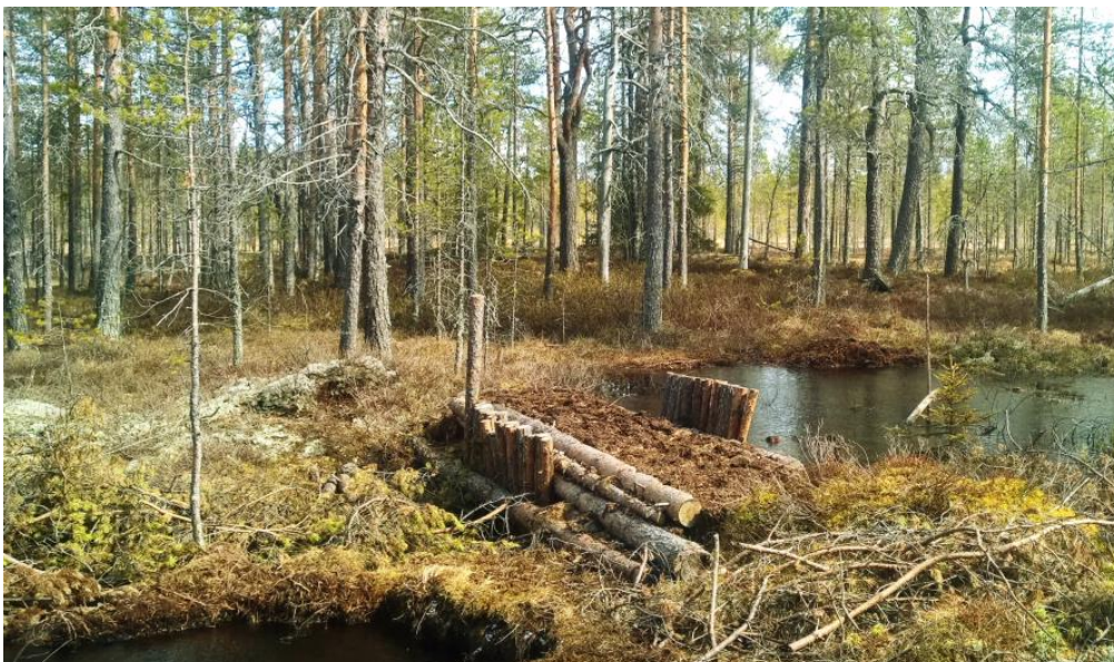
Saarekkeen laitaaan jouduttiin rakentamaan poikkeuksellisen korkea pato, jonka kehikoon ladottiin vaakapuitakin useaan kerrokseen. Riittävän korkealla ja järeällä padolla virtaus saatiin kääntymään haluttuun suuntaan ojasta suolle. Multia, Köpinneva. Kuva: Ari Aalto.
