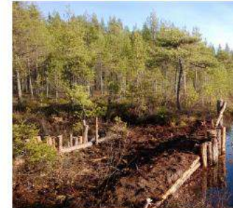
Keskeisellä paikalla isossa ojaassa oleva ja siksi pitkäksi rakennettu ja vesi nousee turvetäytön eturunaan yli alhuttaen tiikumista ja käteen (alhaalla) lisäämällä yhdet vaakapuut vajaan metrin etäällä väli tiivistä turpeella. Keuruu, Kalkusuo. Kuvat: Ari Aalto.
