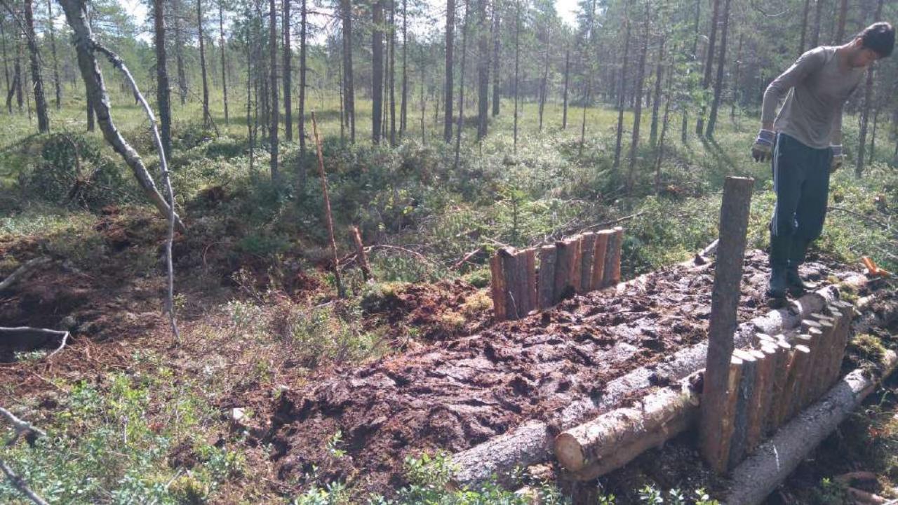
Padon rakennus syksyllä 2016
